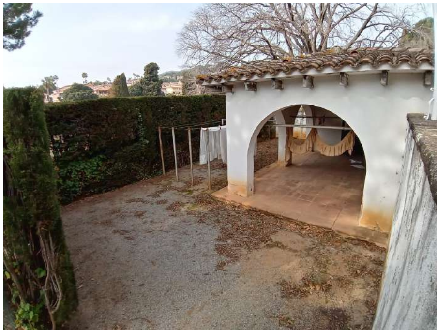
Fig. 49. Edifici destinat a bugaderia.
