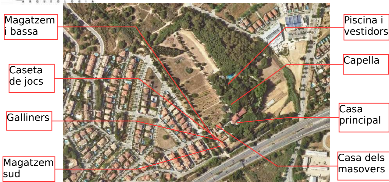
Fig. 3 Principals edificis de la finca
